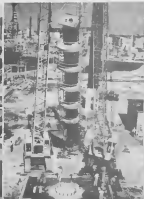
RIGGERS RECIENTEMENTE a pone tres grua di binti-cinco ton capacidad na trabao recientemente pa hiza e tower aki di cincuenta ton cual lo purifica feed gas pa e planta di amonia di A.C.C. E trabao tabata leuw for di rutina. E torre mester a worde lantá mientras e ta equíp cu plataforma, trapu y cable.
